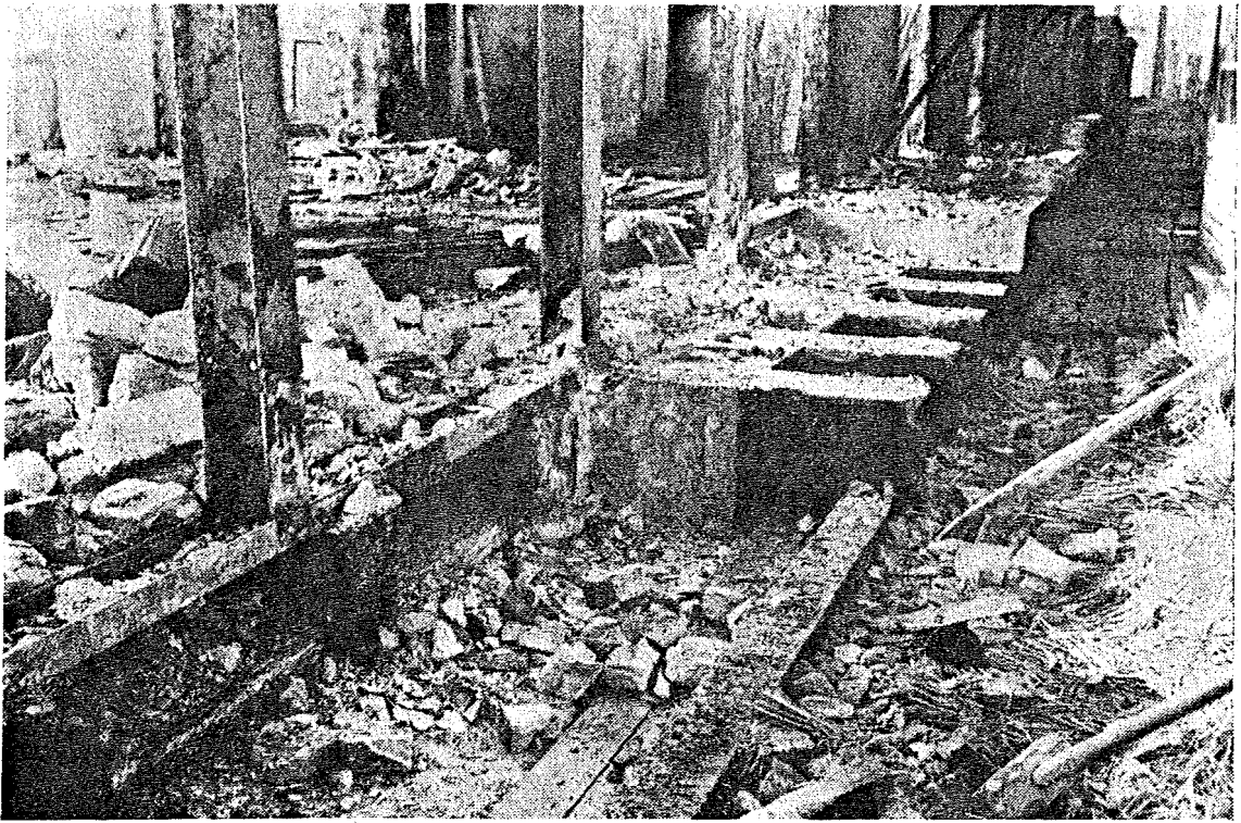
Billedet giver et indtryk af konstruktionen med stolpevæggen lodrette søjler og fordelingsjernene, der hviler på træbjælkelag. På den midterste del af billedet er konsollerne blottet efter altanpladens borthugning. Den foranliggende bræddebælgning er stilladsets gangbro.
